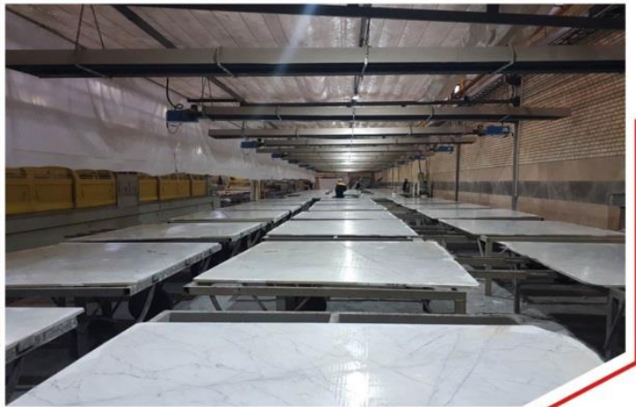
سیستم گرمایش تابشی لوله ای در فرآوری سنگ اسلب
